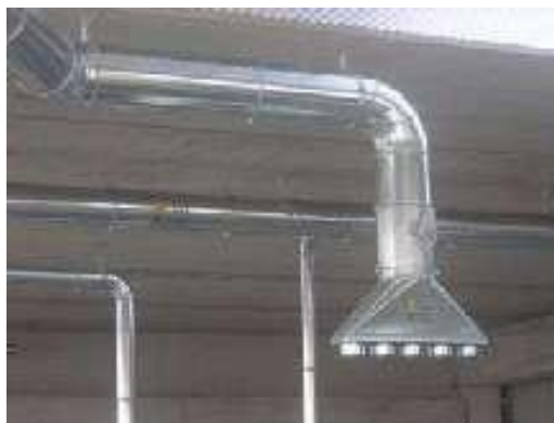
Collettori con risvolto Esecuzione in lamiera zincata Branches made of folded-up galvanized sheet metal
